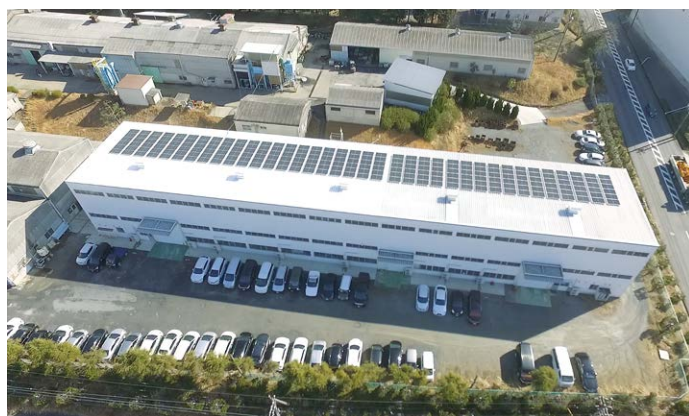
太陽光発電を備えた滋賀工場
